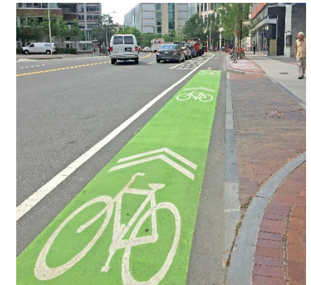
Marcas de Pavimento Verde en la Ciclovía
