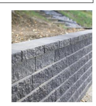
**RETAINING WALL- Sample** DECORATIVE SPLIT FACE BLOCK WALL WITH TOP CAP
